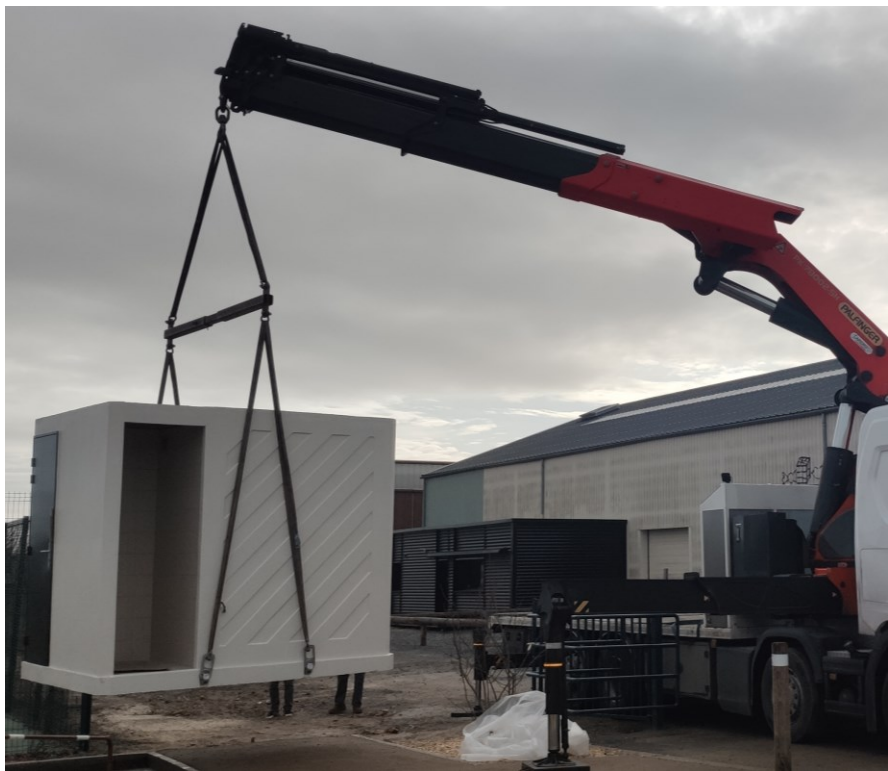
Pose par camion-grue
