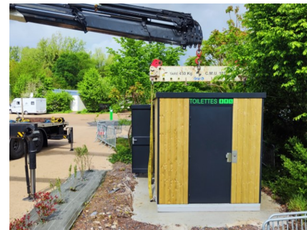
Livraison au camion-grue
