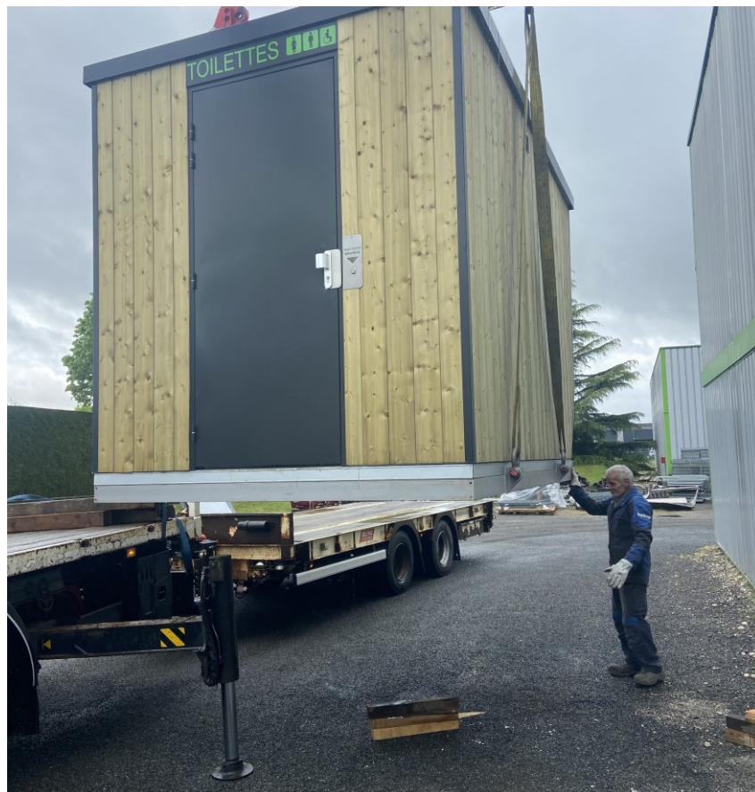
Levage par anneaux intégrés à la dalle
