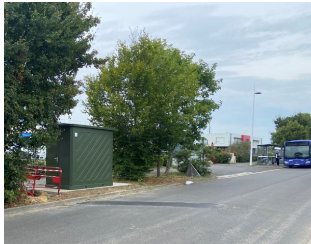
Intégration sur site
