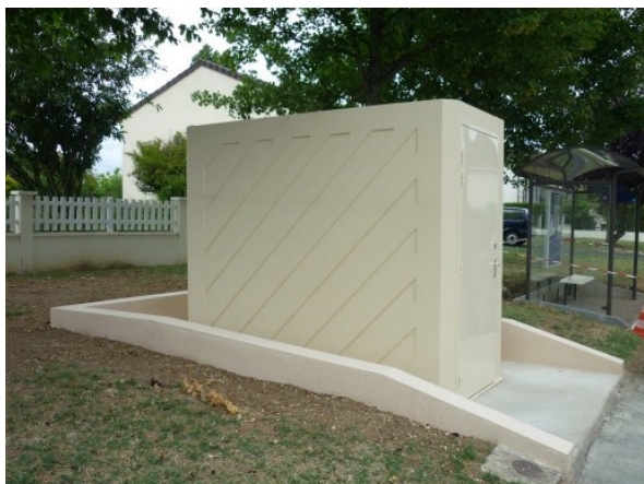
Habillage minéral / béton
