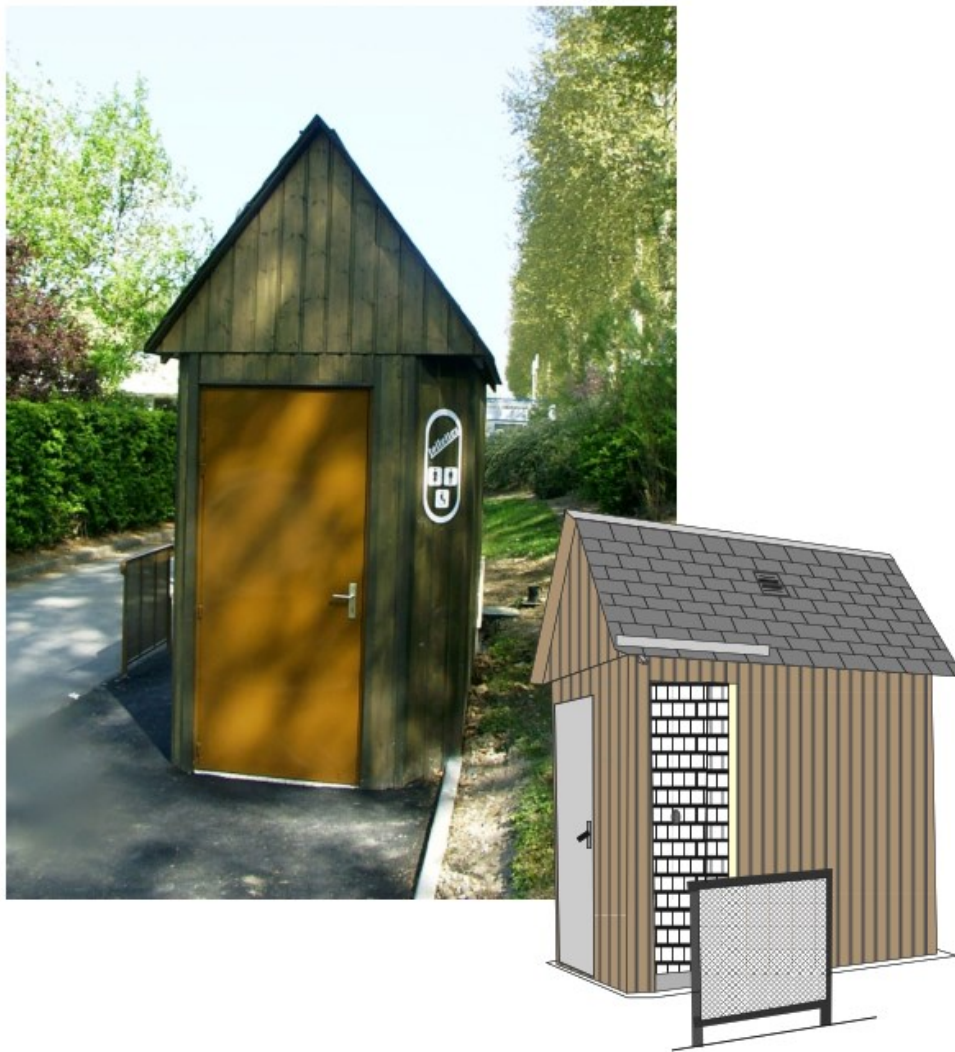
Toiture double pente et bardage bois naturel
