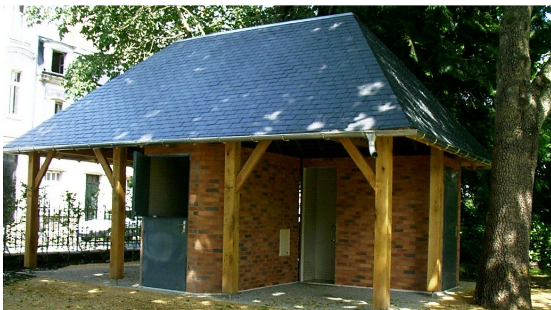
Livraison par camion-grue et pose sur dalle préparée — manutention par 4 points de levage ARTÉON 5 T intégrés à la dalle (poids 5 à 7 T).
