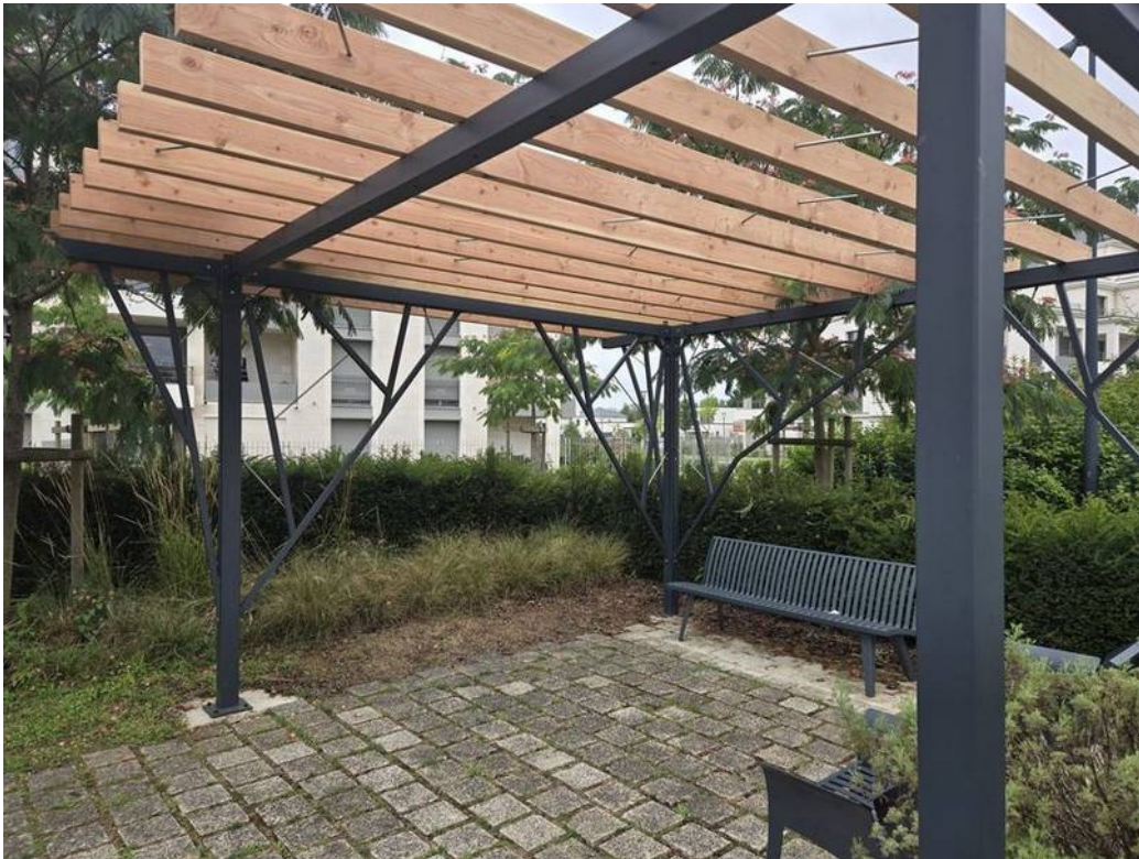
Bancs acier sous pergola
