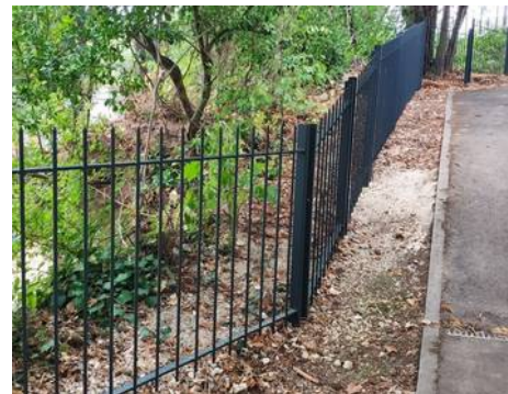
Clôture basse en talus
