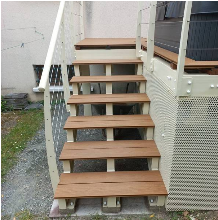
Plateforme spa : structure acier, escalier et garde-corps câbles
