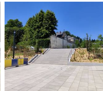
Escalier et main courante
