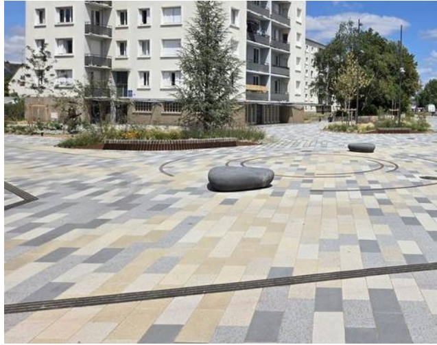
Marquages au sol corten
