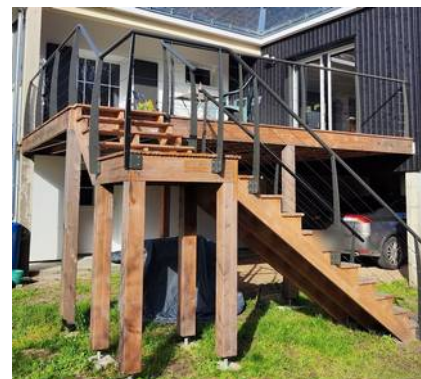
Garde-corps de terrasse privée
