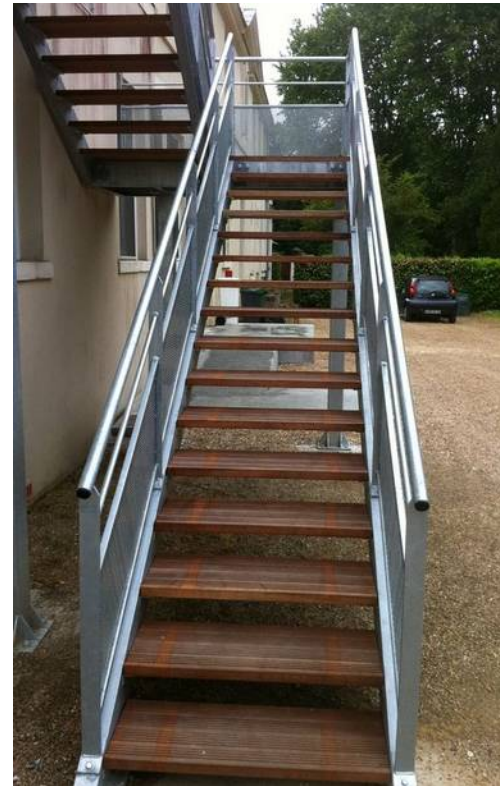
Escalier extérieur galvanisé, marches bois
