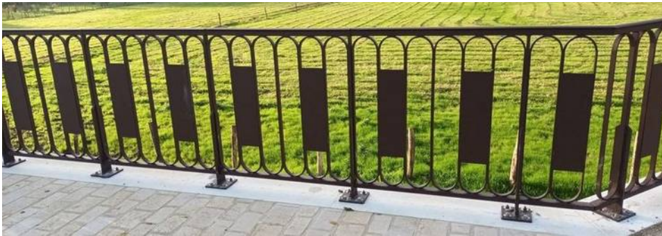
Pont du lavoir, RD105, Champniers (2024) – Département de la Charente
