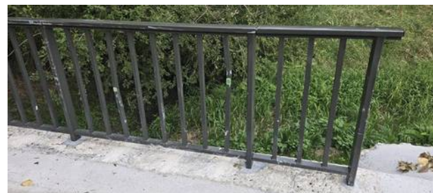
Garde-corps, remplacement de barreaux (2025), pour une entreprise de TP
