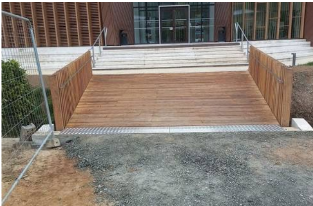
La même passerelle, platelage et garde-corps bois
