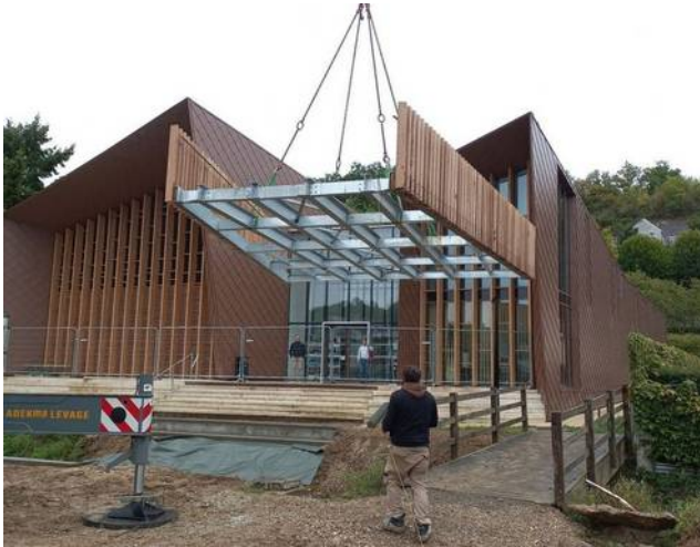
Levage d'une passerelle, Rochecorbon (2022)
