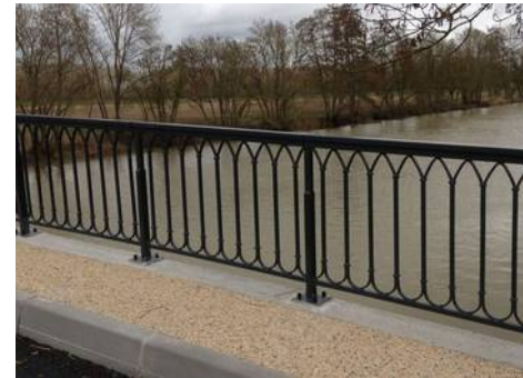
Garde-corps de pont sur l'Indre
