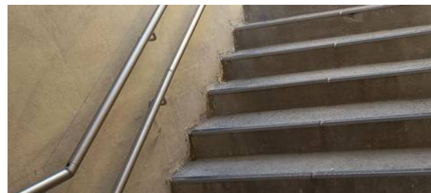
Main courante, gare de Chartres (2025), pour une entreprise de TP
