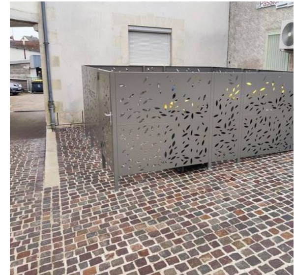
Abri de conteneurs en tôle découpée
