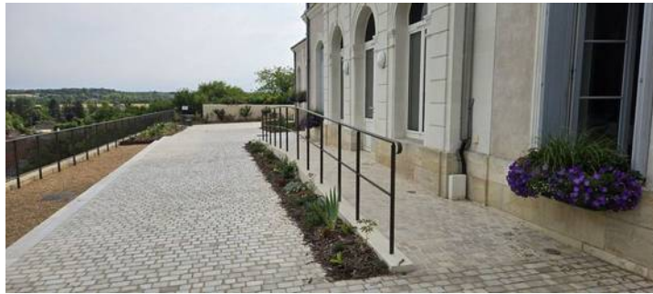
Rampe PMR et main courante
