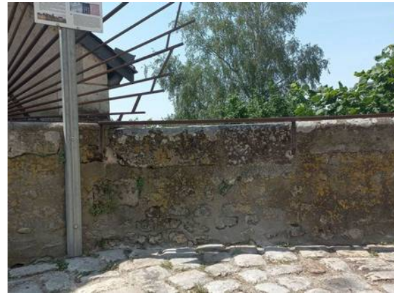
Grille et main courante sur mur ancien
