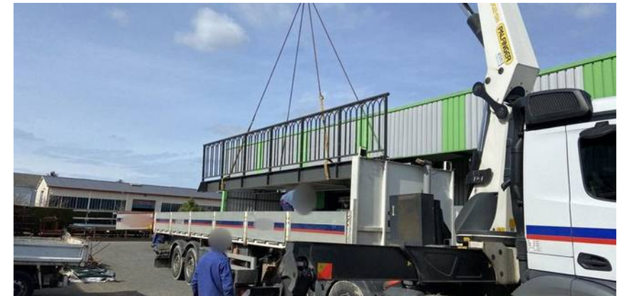
Chargement d'une passerelle à l'atelier
