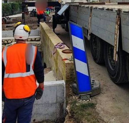
Pose à la grue, Savonnières (2023)
