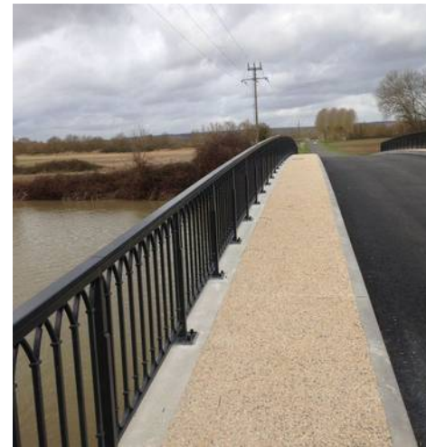
Pont de Blacas sur l'Indre
